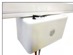
Bild 5: Kabeln från åkvagnen kopplas in
